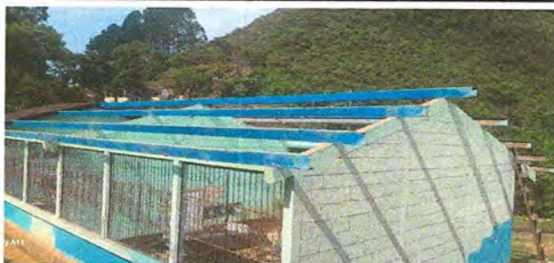
Foto1: Cambio de pintura de las costaneras
