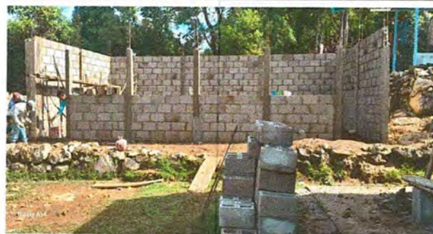
Foto 2: Construcciones de las ventanas
