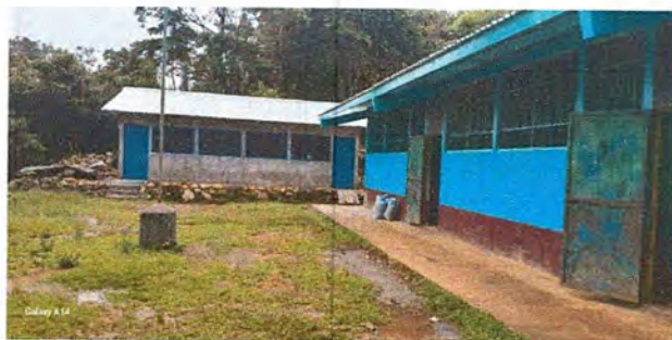
Foto 6: Instalaciones de puertas de la cocina
