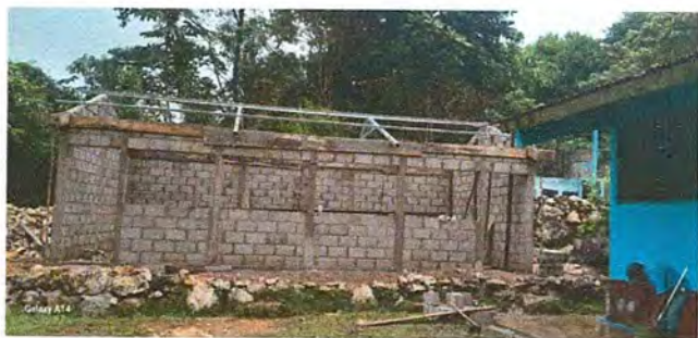
Foto 3: Instalaciones de costaneras de la cocina
